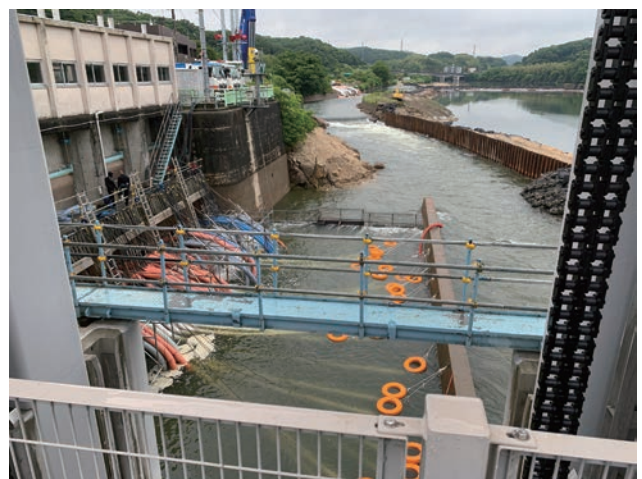
写真 2-1-2 ポンプで緊急給水する明治用水。筆者撮影
