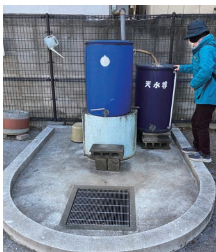
写真 1-2-1 民家の雨どいに接続され、近隣住民が使用できる雨水タンク。東京都墨田区、筆者撮影
