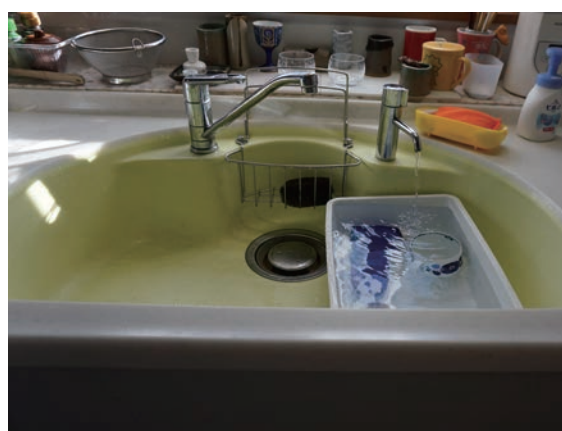
写真 1-2-6 台所の雨水水栓。筆者撮影
