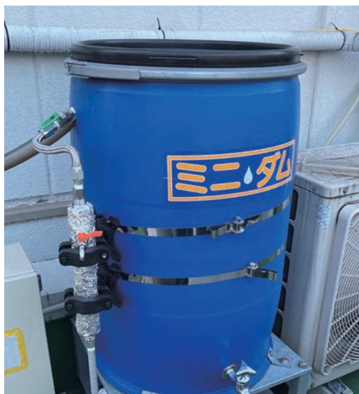
写真 1-2-7 ろ過装置を取り付けた小型雨水タンク。東京都文京区、筆者撮影
