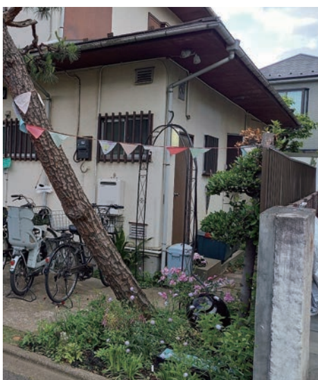
写真 1-2-3 個人宅の庭の一角に設置された「雨庭」。中央の豎樋からの雨はアーチを經由して地下30cm程に設けられた礫層に一旦貯留され、さらに下にゆっくり浸み込む。東京都世田谷区、筆者撮影
