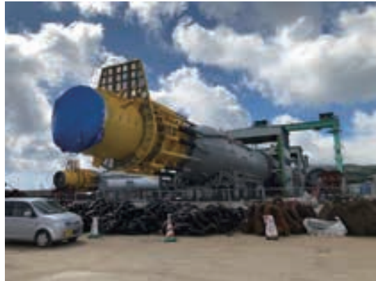
写真1 ヤードで建造中のハイブリッドスパー型浮体
